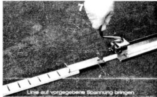
7 Linie auf vorgegebene Spannung bringen
